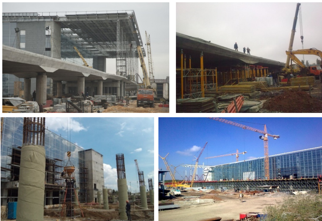
Fot. 1. Przykład pielęgnacji świeżego betonu w elementach pionowych
